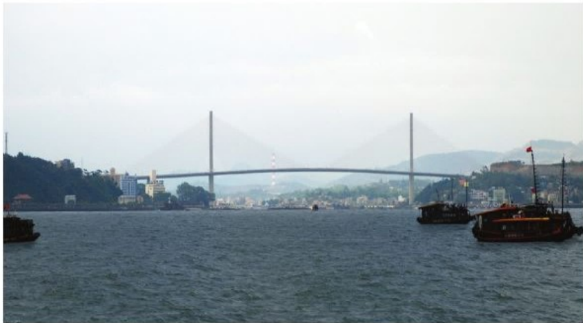
Cầu Bãi Cháy (Nguồn: https://commons.wikimedia.org )
